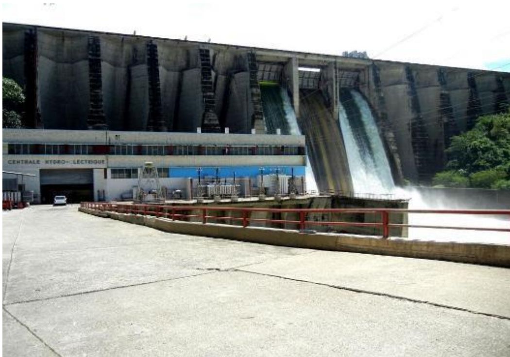
Figure 2: Image présentant la centrale hydroélectrique de Péligre
