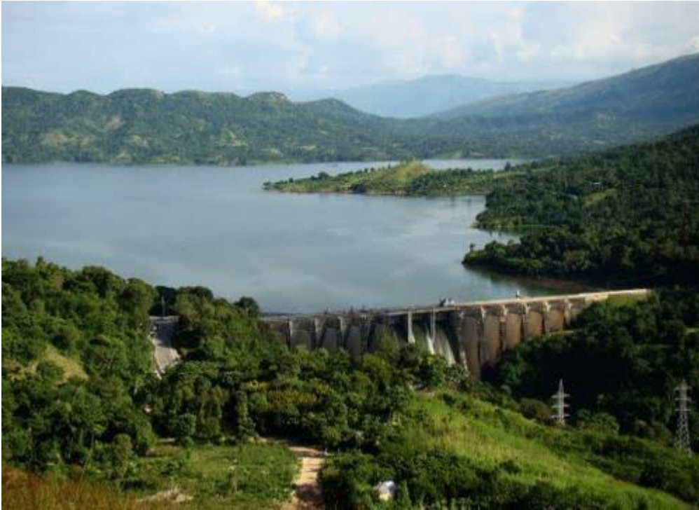
Figure 1: Présentation du barrage hydroélectrique de Péligre
