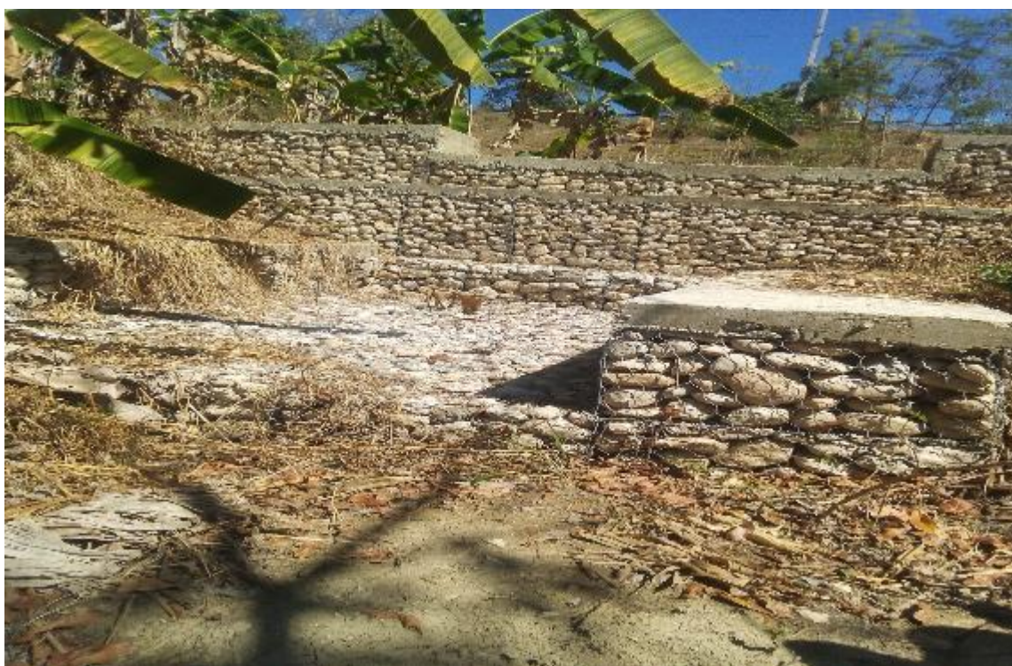
Figure 14 : Structure en Gabion dans la ravine de Nifyèn
