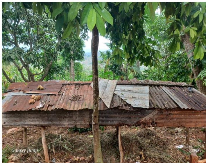
Photo 3: Face arrière d'un clapier observé (prise au moment de l'enquête)
